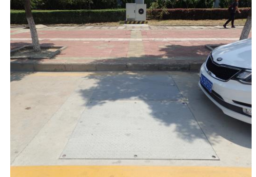
横2連の車上コイル、地上コイルと正着用ハンパ、コイルと電源盤の位置関係
