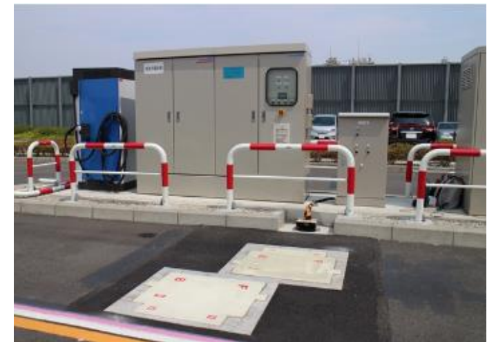
1次コイルの設置状況
