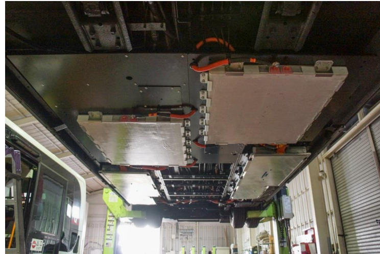
2次コイルの設置状況
