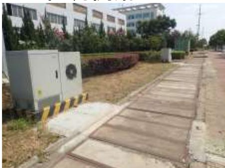
2基の120kW電源盤と冷却システム、
