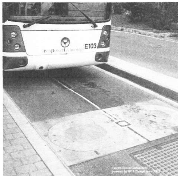
図10 ジェノア市に設置された IPT システム
