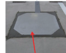
地上面と面一になるように地中にコイルを埋め込む
