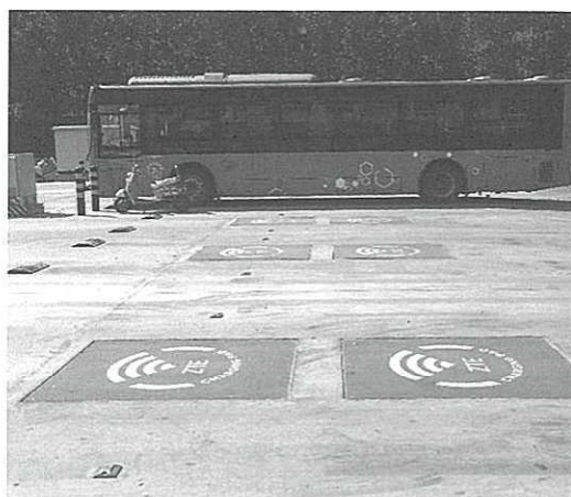
写真5 ZTEのワイヤレス給電コイルと電動バス 広い営業所敷地に10基のシステムが運用されている
