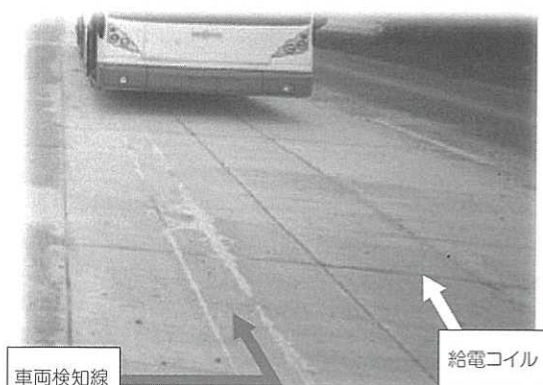
図10 コンクリート舗装路への埋設状況 (10)
