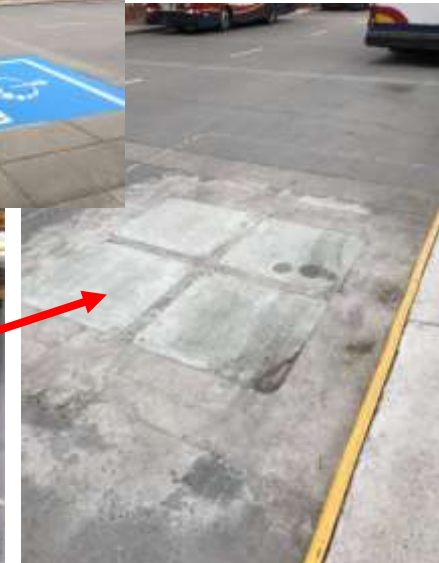
地上コイルの設置状況 50kWコイル × 4 (カバー貼り付け前)
