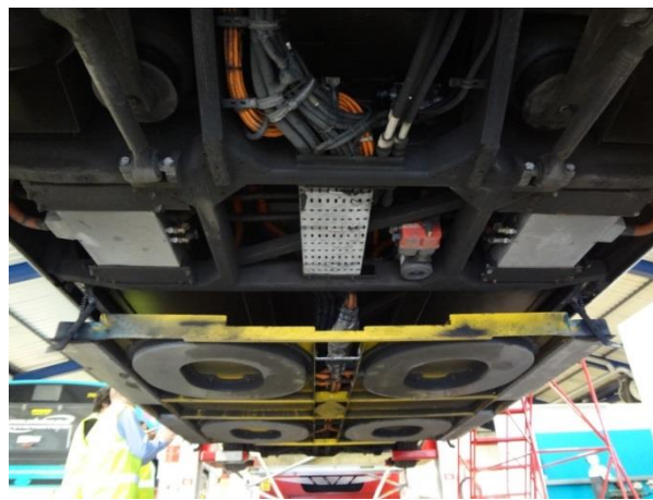
2次コイルの設置状況
