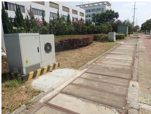
120kW電源盤(2基)と冷却システム、 奥の高圧電源(160kVA)
