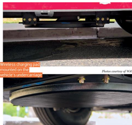
2次コイルの設置状況
