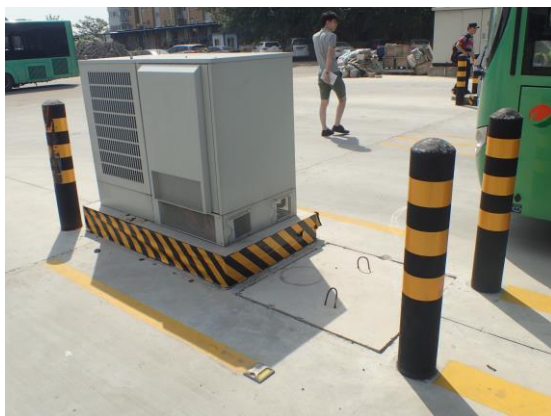
120kW電源盤と冷却システム(5基)
