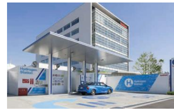
水素ステーション
